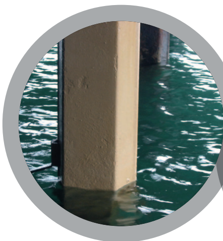
コンクリート柱
